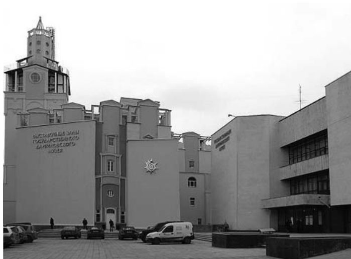
Рис. 6. Дарвиновский музей. Справа здание, открытое в 1994 г., слева – хранилище и выставочные залы, открытые в 2007 г. к 100-летию музея
