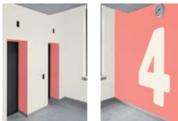
Рис. 2. Компонент доступной среды: лифтовая комната с контрастной окраской стен и откосов
