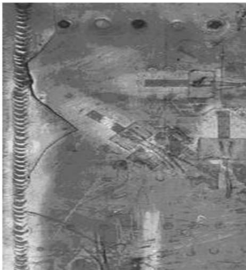
Рис. 3.32. Усталостное разрушение обшивки.
